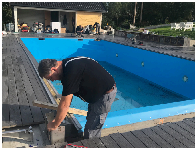
Basseng under arbeid med sveiset liner.
